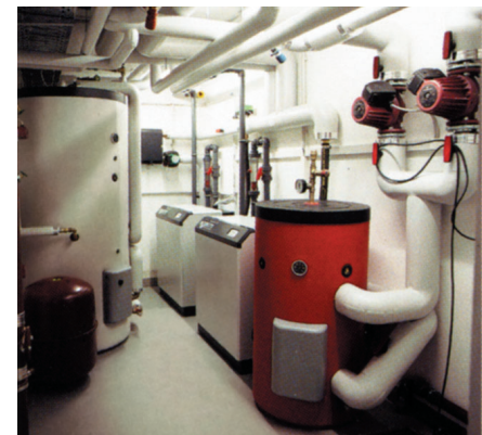
Wärmepumpen-Heizzentrale
